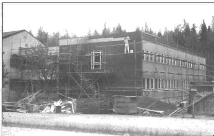
Tillbyggnad av administrationsbyggnaden 1971-72.
