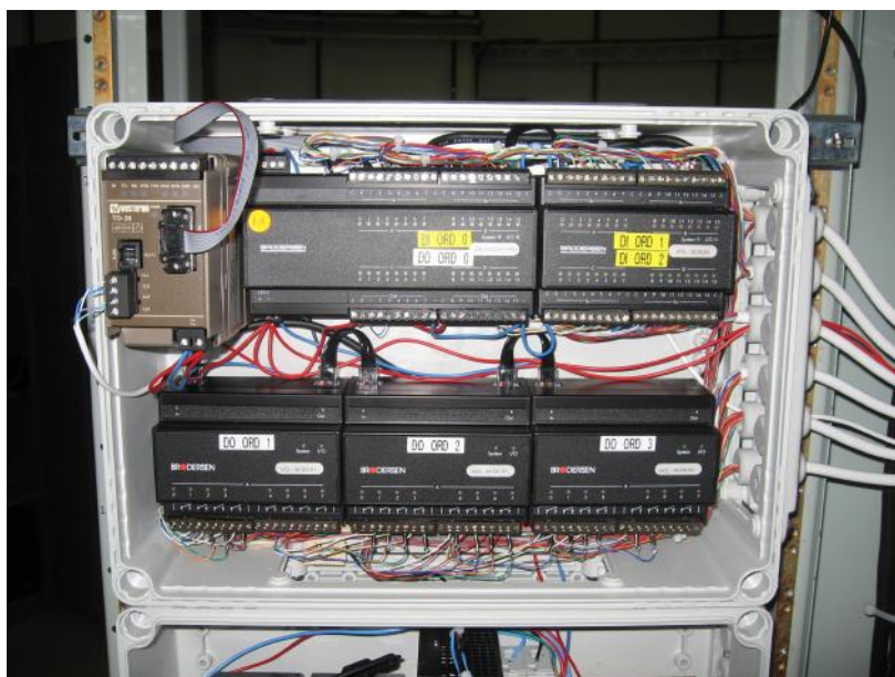
Figur 15: Installation med I/O-system B2000
