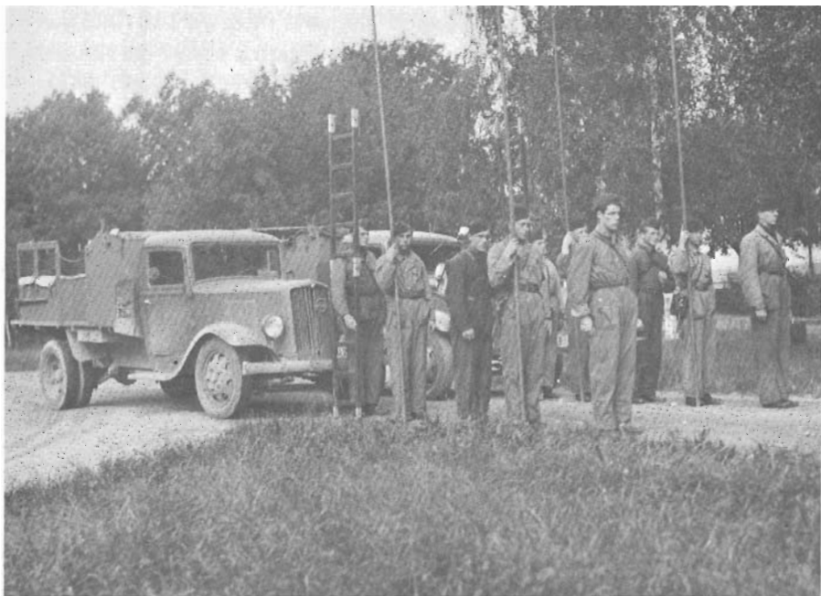
Trådsignalbil med grupp klar för linjebyggnad. Från gruppchef, utstakare, utrullare, utläggare och fästare.
