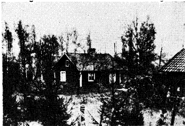
Torpet Haga. Här byggdes CVA motorprovbyggnad. Fotot taget den 31 juli 1944.
